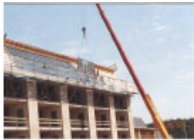
Kuva 3. Ekoviikissä on käytetty ensimmäisen kerran Suomessa suuria keräinmoduleita (10 m 2 ), jotka muodostavat kattopinnan /SOLPROS/. Keräinten asennus kerrostalon katolle kestää 1-2 päivää.
