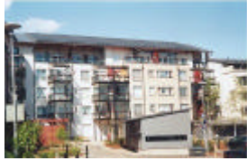
Kuva 1 Aurinkolämpöjärjestelmä Ekoviikin kerrostalossa (aurinkokeräimiä 248 m 2 ) /SOLPROS/.
