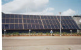
Kuva 1 Aurinkolämpöjärjestelmä Ekoviikin kerrostalossa (aurinkokeräimiä 248 m 2 ) /SOLPROS/.
