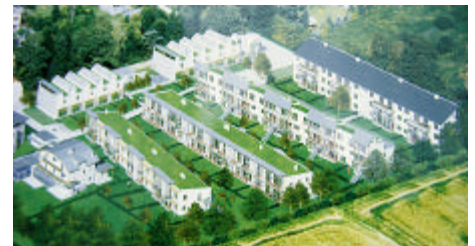
61 asunnon kohteessa Salzburgissa on hyödynnetty aluelämpöratkaisussa aurinkolämpöä. 35-40% koko lämmön tarpeesta tyydytetään aurinkoenergialla. Keräinpinta-ala 410 m 2 ja lämpövaraaja 100 m 3 . /Faninger, 2002/
